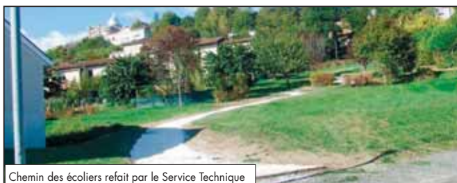
Chemin des écoliers refait par le Service Technique
